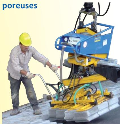
Ou si vous avez besoin d'une solution spéciale adaptée. La combinaison de la puissance TURBO et d'une platine d'aspiration spéciale développée par les ingénieurs de Probst ! Par ex. pour réaliser un appareillage demi-brique avec un bloc de 12 pavés en béton et positionner le tout au millimètre près sur un talus en pente raide – aucun problème avec l'appareil de levage SH-UNI-TURBO.
