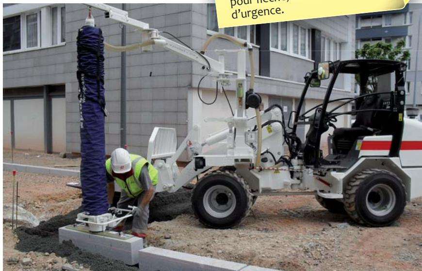
Motorisation: Kubota - 4 cylindres - 60 PS – Vitesse : max. 25 km/h – Hauteur de levage max. de la fourche à palettes 2.670 mm – Charge max. de la fourche à palettes : 2.000 kg – Poids total: ca. 4.100 kg – Dimensions de la machine : L x l x H (mm) 5.270 x 1.560 x 2.650
