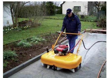
... pour le jointoiment des pavés : le pack complet pour économiser les efforts – la jointoyeuse de pavages EASYFILL EF-H.
