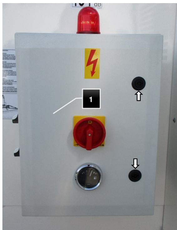
Fig.86 : Ouvrir la porte de l'armoire de distribution
