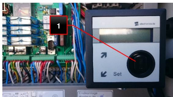
Fig.220 : Commande moteur diesel
