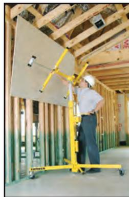
Un vérin d'orientation permet un positionnement optimal.
